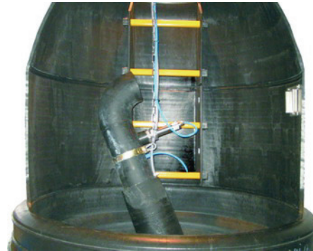
NPP – Instalação numa caixa de visita
