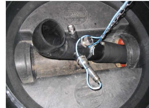
NPP – Instalação numa caixa de visita
